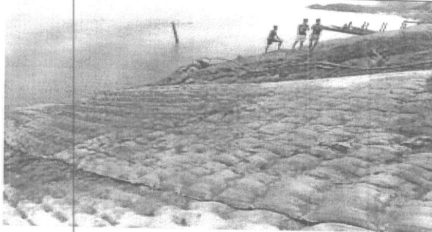
COLCHACRETO es el nombre de las formaletas textiles diseñadas para ser llenadas con concreto hidráulico de agregado fino y obtener revestimientos de formas predeterminadas aplicables en obras civiles en seco, a borde de agua o bajo agua, de manera mas versátil y económica que los revestimientos convencionales con concreto.
